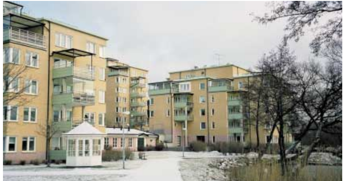
Husens läge vid strandkanten av Ulvsundasjön är idealiskt för sjövärme.
