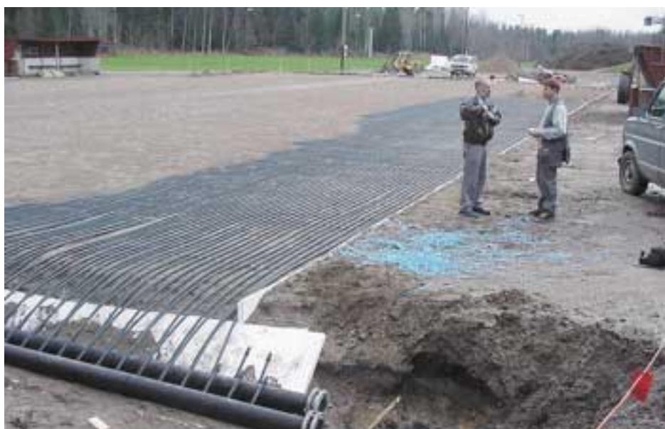
Medlemmarna var med och lade ut 18 km slang som gick åt för att både få fin is och bra värme i skolan. Foto t.v. Marcus Tärnvik, t.h. Inger Grönlund.
