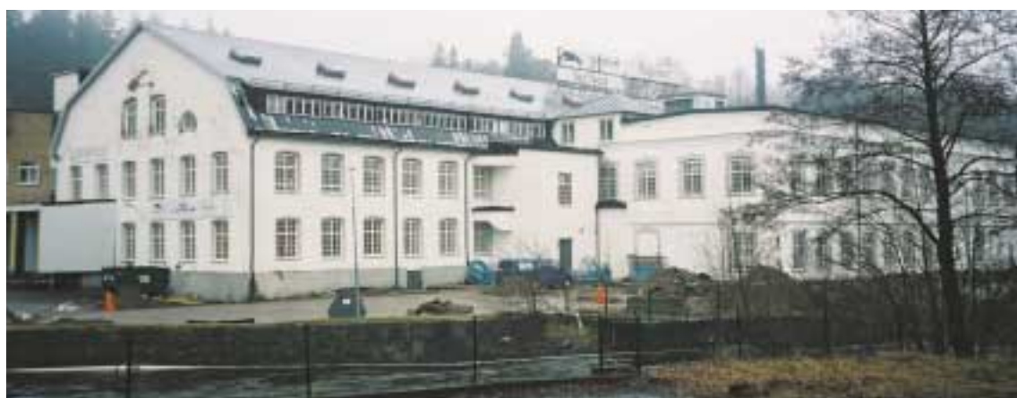
Rydboholms klassiska industribyggnad är idag modernt logistikcenter.
