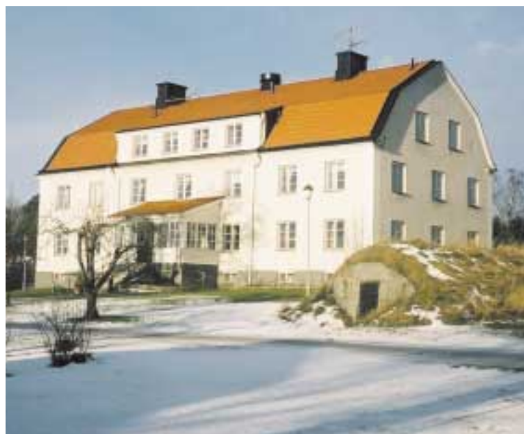
Det ursprungliga fattighuset rymmer hotellrum och värmecentraler. Konferens- och restaurangutrymmena finns i en annan byggnad till vänster om bildkanten.
