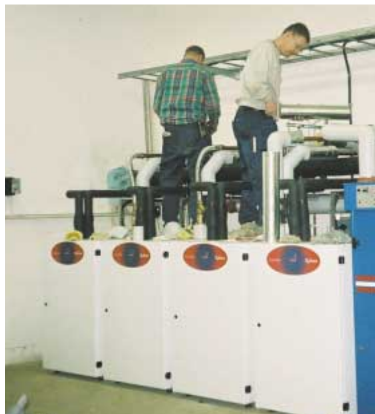
Installationen av de fyra Thermia värmepumparna i Viskafors avslutas med rörisolering.
