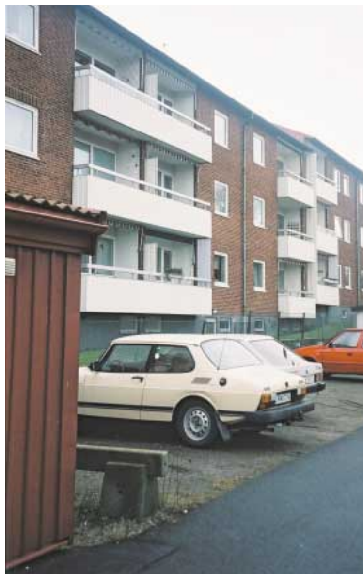
Finns Sveriges snyggaste pannrum i en av byggmästare Bengtssons fastigheter? (ovan och t.v.)
