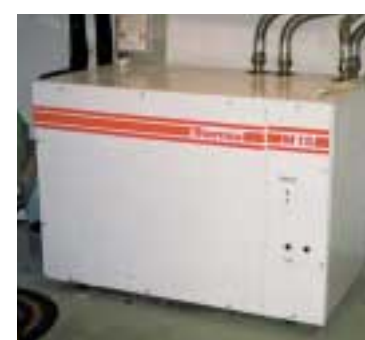
Folkets Hus-föreningens räddare – en värmepump Thermia M15. "Vi fyllde tanken med 1,5 m 3 olja 1991 – och det räcker än" säger Torbjörn Ljungqvist.
